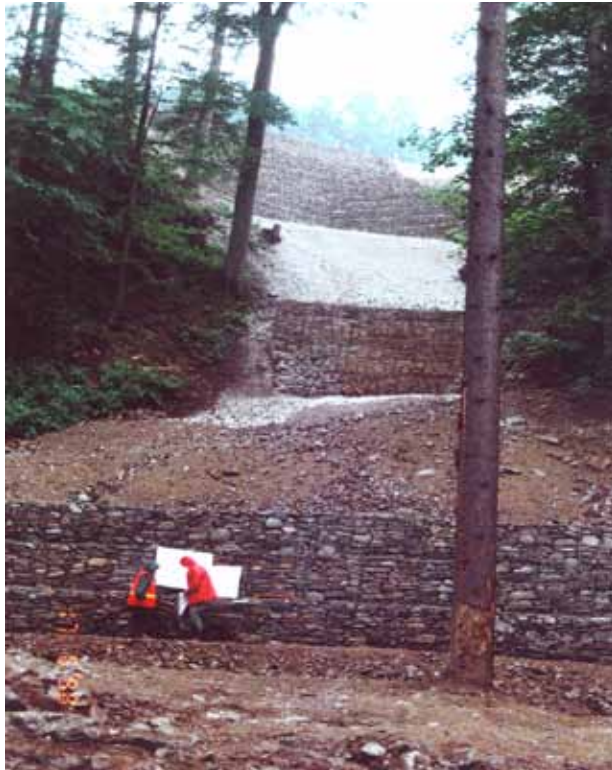
Fot. 3. Osuwisko skarpy drogi nr 45109 w Międzygórzu – konstrukcja zabezpieczenia skarpy drogowej systemem gabionów
