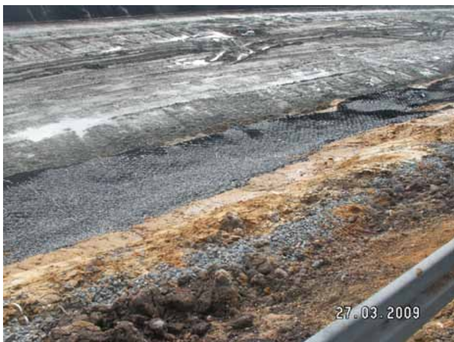
Fot. 3. Widok na skłon skarpy wykopu na analizowanym odcinku autostrady
