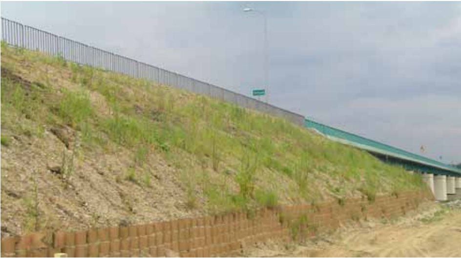
Fot. 3. Widok skarpy po wzmocnieniu kolumnami żwirowymi i wykonaniu muru oporowego przed wykonaniem zabezpieczenia powierzchniowego skarpy
