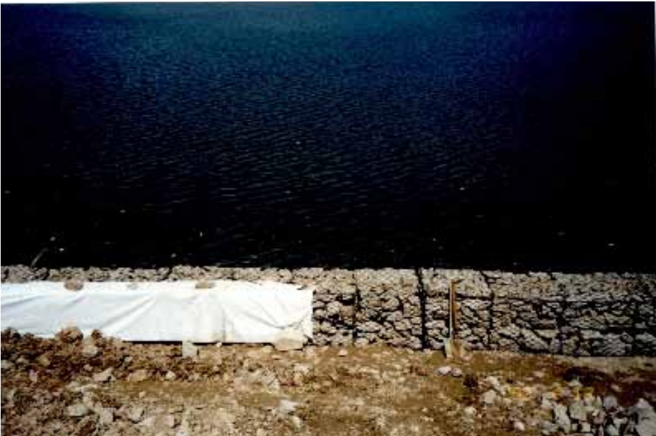
Fot. 6. Widok z góry na przyporę wykonaną z gabionów z włókniną układaną od strony stoku
