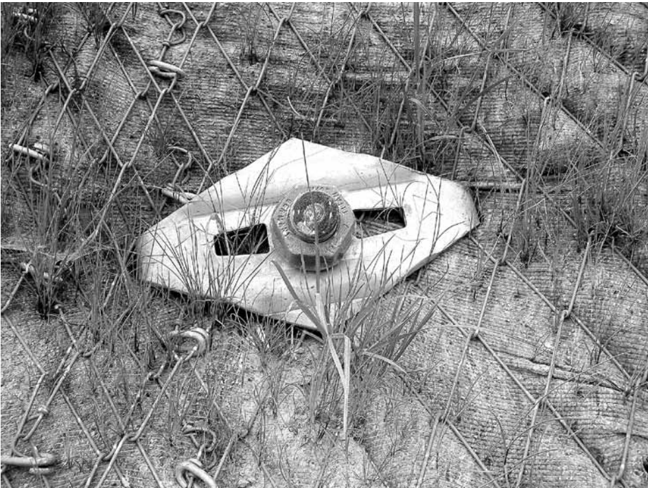
Fot. 1. Główne elementy konstrukcji – gwoździe gruntowy TITAN, system TECCO: siatka stalowa, płytki kotwiąca, łączniki zaciskowe
