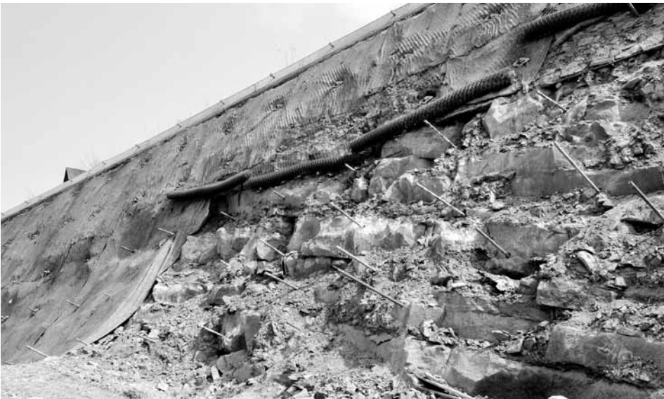
Fot. 8. DE S7, Lubień, zagwoździowana skarpa w trakcie mocowania systemu TECCO
