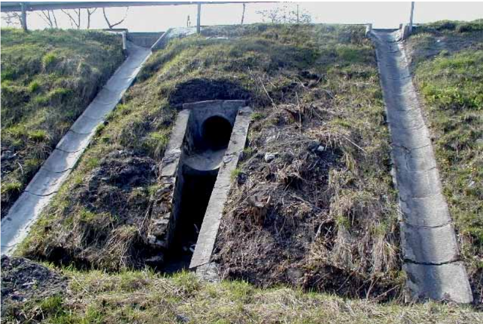
Fot. 14. Osuwisko po doraźnym zabezpieczeniu – uszczelniona powierzchnia południowej skarpy, oczyszczony i odbudowany wylot odwodnienia odprowadzającego wodę z pasa zieleni rozdzielającego jezdnie ruchu
