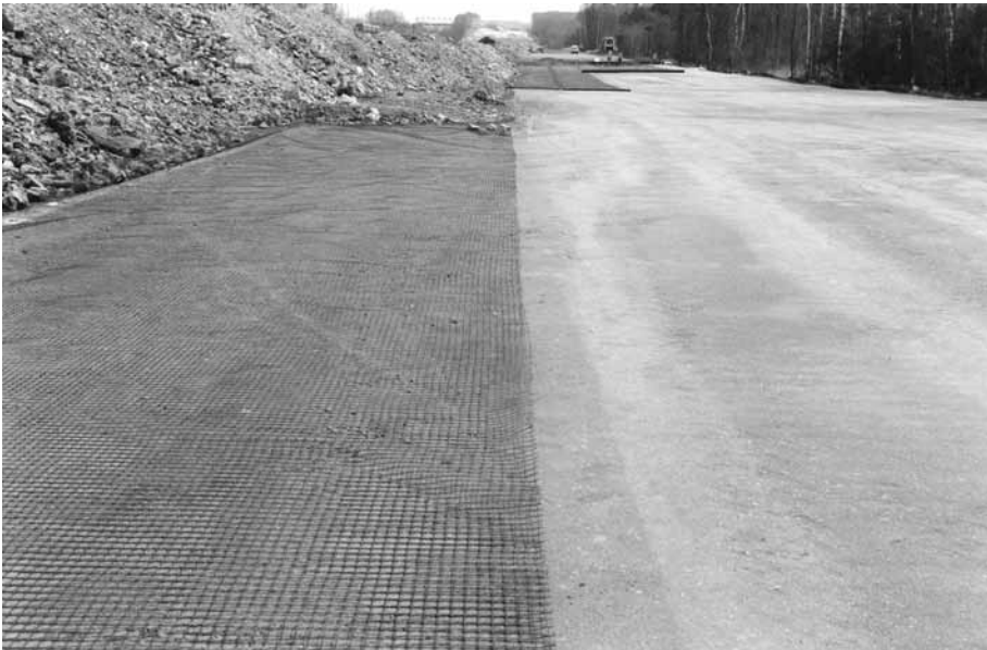
Fot. 2. Układanie górnej warstwy geosyntetyku w materacu pod nasypem autostrady
