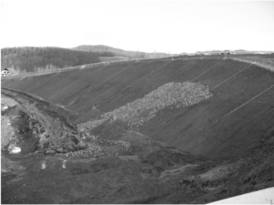
Fot. 1. Skarpa dwuwarstwowa: warstwa dolna - łupki ilaste, górna - ruMosze gliniaste
