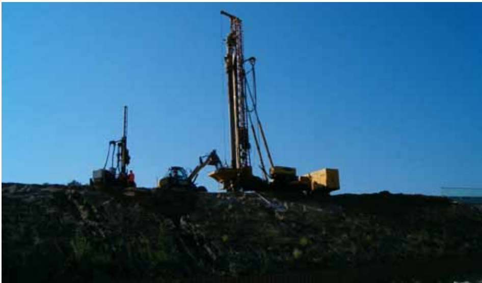
Fot. 1. Wzmocnienie podłoża wzdłuż drogi
