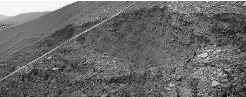
Fot. 13, 14. Wymycie filtracyjno-sufozyjne połączone z obrywem utworów pokrywowych - Obejście Lubnia
