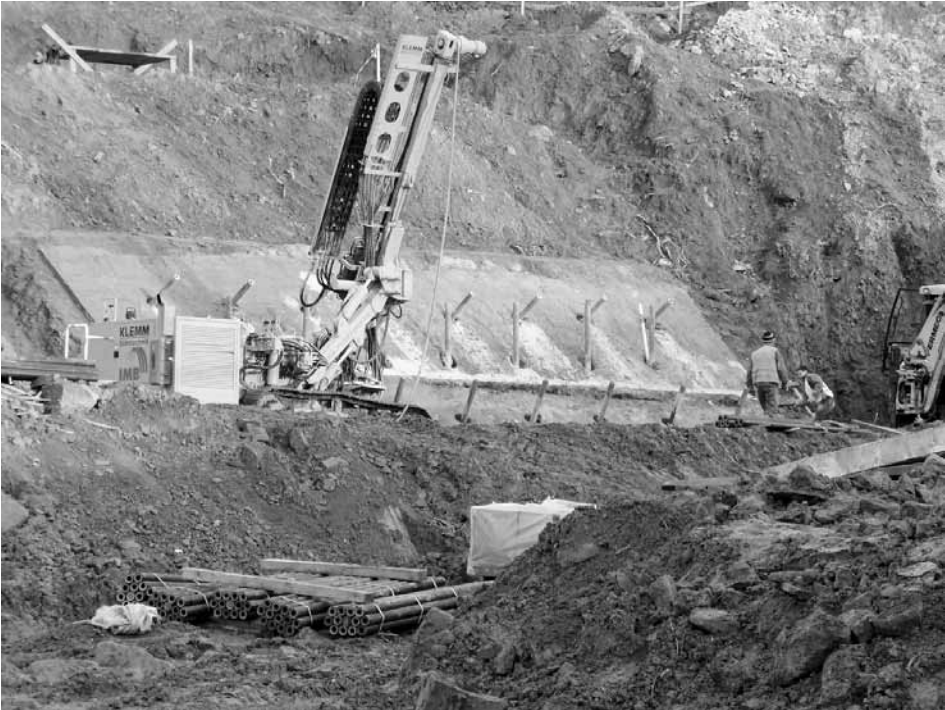
Fot. 2. Fundament dźwigaru łukowego w trakcie wykonywania mikropali, fot. A. Kulawik
