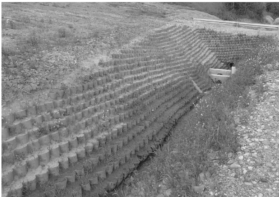
Rys.12 Zabezpieczenie skarpy, włączenia drenu francuskiego i wlotu do przepustu.
