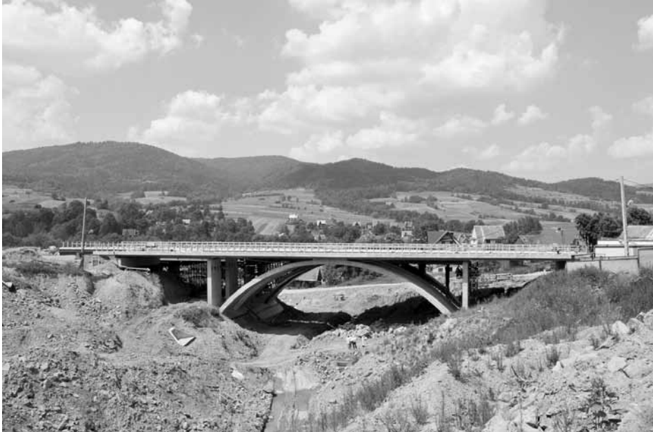
Fot. 3. Most łukowy w ciągu DE S7 Kraków-Rabka, m. Lubień, z fundamentami mikropalowymi, fot. arch. TITAN POLSKA
