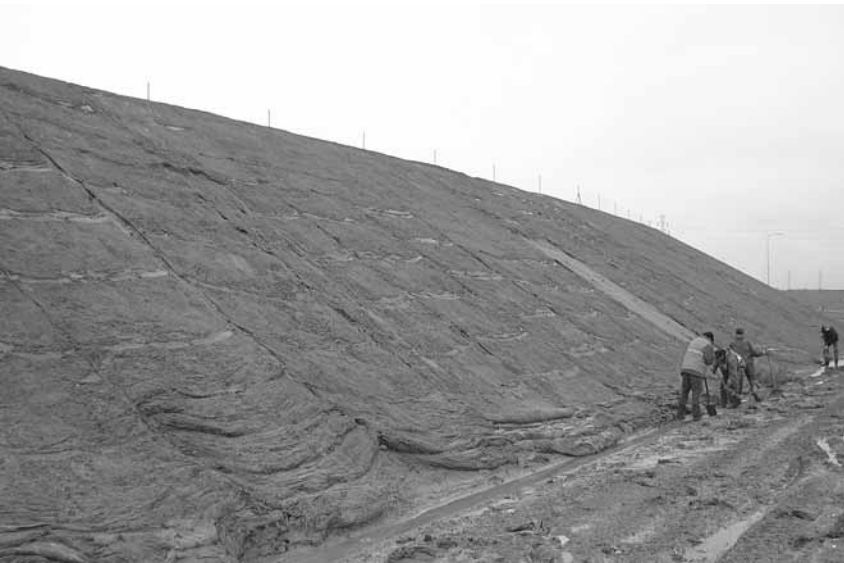
Fot. 9, 10. Zsuwy warstwy humusu - Autostrada A4
