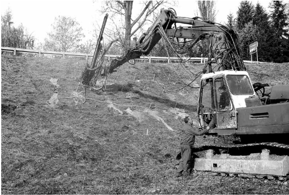
Fot. 4. DK 69, wykonywanie gwoździ gruntowych systemu TITAN
