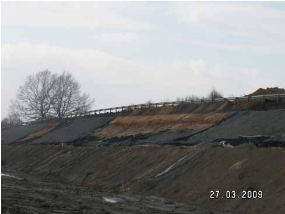
Fot. 1. Widok na osuwisko wzdłuż projektowanej autostrady
