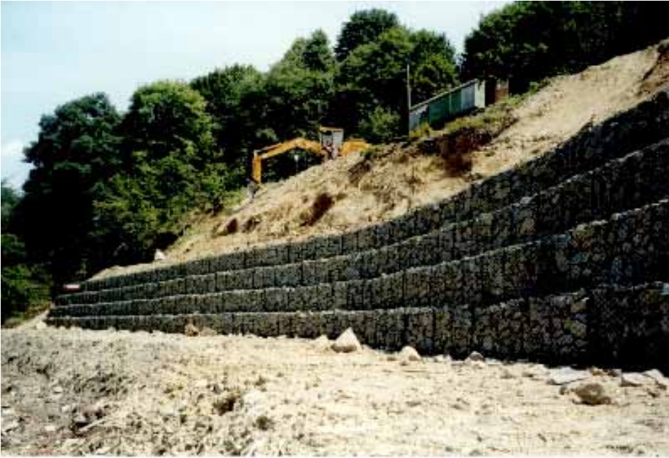
Fot.5. Widok ułożonej przypory zabezpieczającej podnóże skarpy, wykonanej z gabionów
