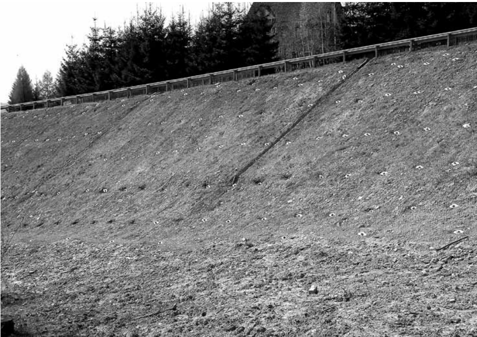
Fot. 5. DK 69, zabezpieczony osuwiskowy korpus drogowy w miejscowości Węgierska Górka
