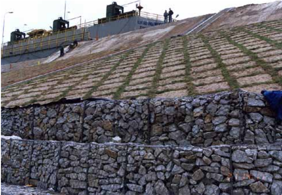
Fot. 2. Prace przy odbudowie nasypu drogowego
