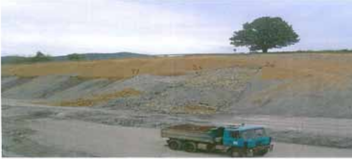
Rys. 8. Zjawiska osuwiskowe w skarpie
