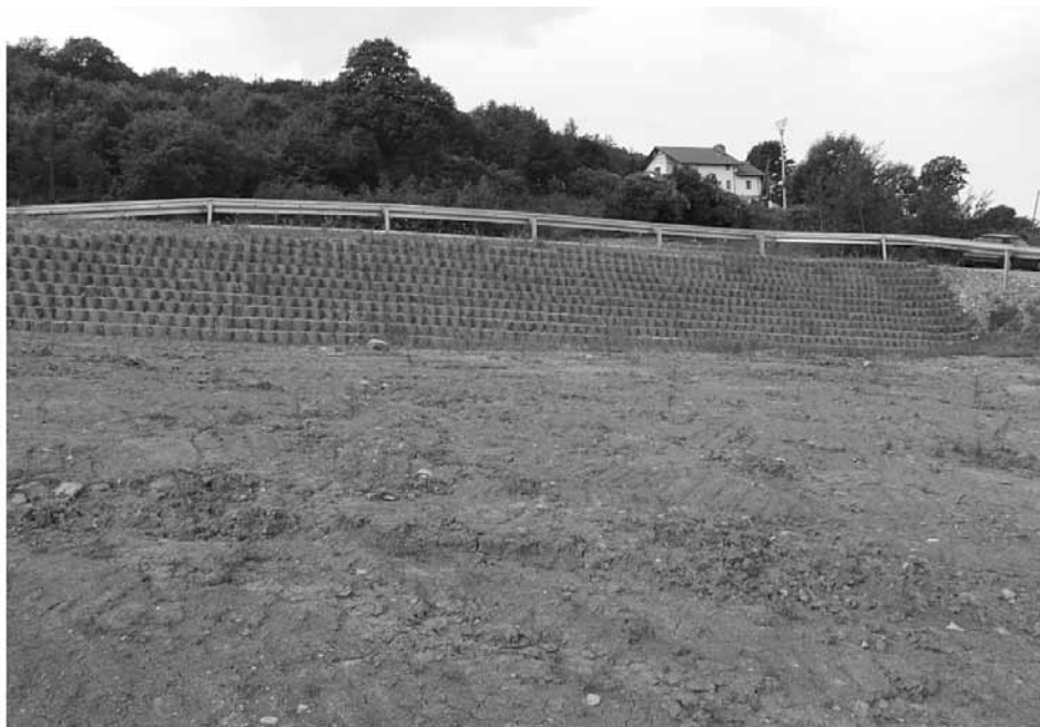
Rys.11 Zabezpieczenie korpusu drogowego
