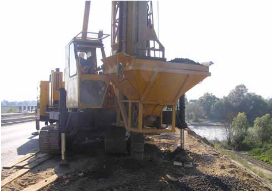
Fot. 2. Wprowadzanie kruszywa w podłoże poprzez wibrator śluzowy
