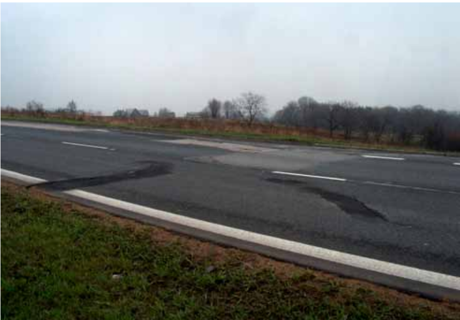
Fot. 29. Duże deformacje lewej jezdni DK 7 w m. Mogilany po sezonie zimowym 2003/2004 (marzec 2004r.)
