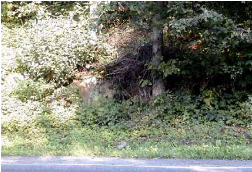
Fot. 6. Droga prowadzona w sąsiedztwie dużego górotworu wymagała dodatkowego zabezpieczenia przez osuwającymi się masami gruntu, pomimo występujących tu płytko pokładów piaskowca magurskiego. Właśnie z takich bloków kamiennych wykonano umocnienia na przeciwskarpie rowu, utrzymując w stabilności grunt powyżej. Obecnie górotwór pokryty jest lasem mieszanym, stok nie wykazuje wysięków wody i brak jest jakichkolwiek zauważalnych oznak uaktywnienia się tutaj form osuwiskowych. Km 709+180, strona prawa drogi, miejscowość Pcim
