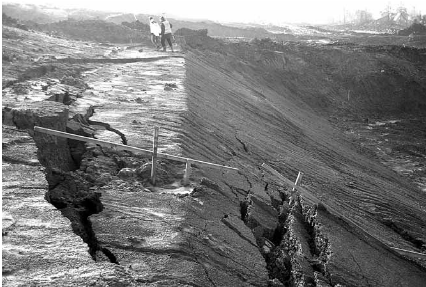
Fot. 15. Osuwisko strukturalne – Obejście Lubnia
