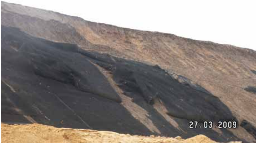
Fot. 4. Zsuw mat antyerozyjnych stanowiących tymczasowe zabezpieczenia na analizowanym odcinku autostrady
