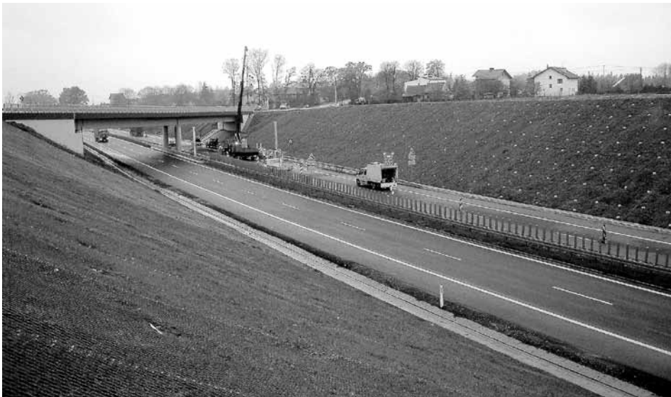
Fot. 3. DE S1, widok skarpy osuwiskowych po zabezpieczeniu
