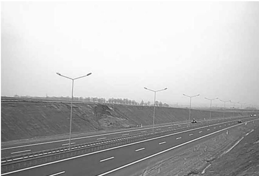
Fot. 1. Osuwiska - Autostrada A4
