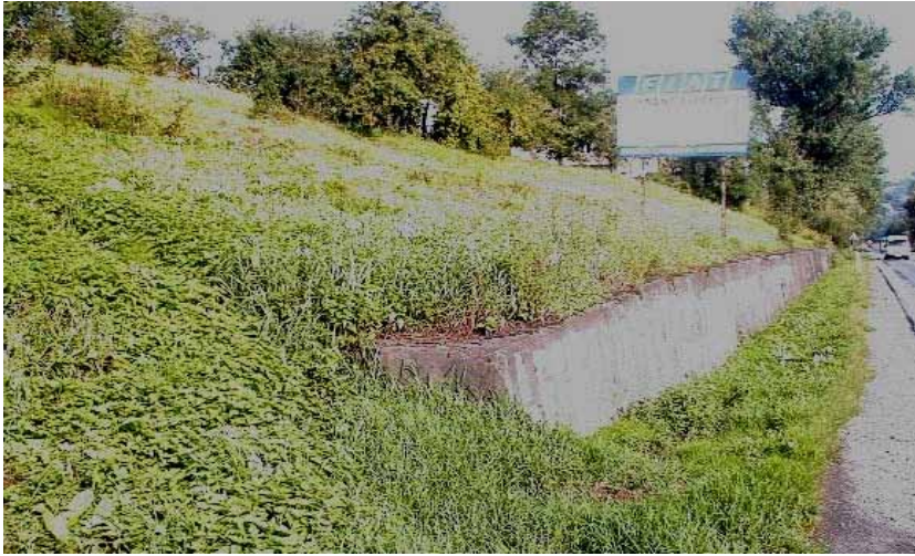
Fot. 5. Mur oporowy zabezpieczający zbocze górotworu sfałdowanego w wyniku procesów osuwiskowych. Konstrukcja nie wykazuje zniszczeń, osuwisko jest stabilne, nieaktywne. Km 704+350 – 704+435, strona prawa drogi, miejscowość Stróża
