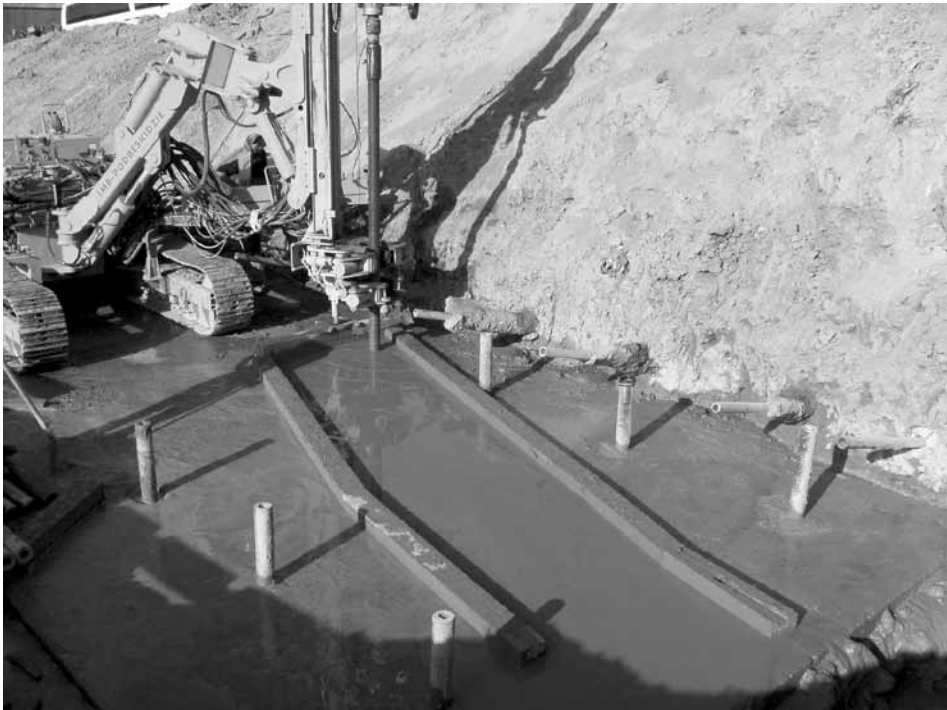
Fot. 1. Wykonywanie mikropali w fundamencie przyczółka
