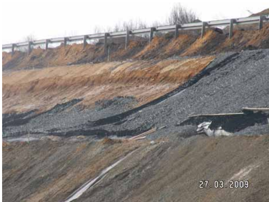
Fot. 2. Zsuw geokrat na omawianym odcinku autostrady
