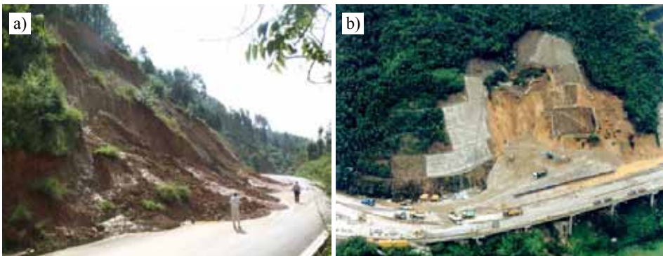
Rys. 1. Przykłady zniszczeń infrastruktury drogowej w Chinach: a) droga nad rzeką czerwoną w prowincji Yunnan, b) droga Ching - Cheung
