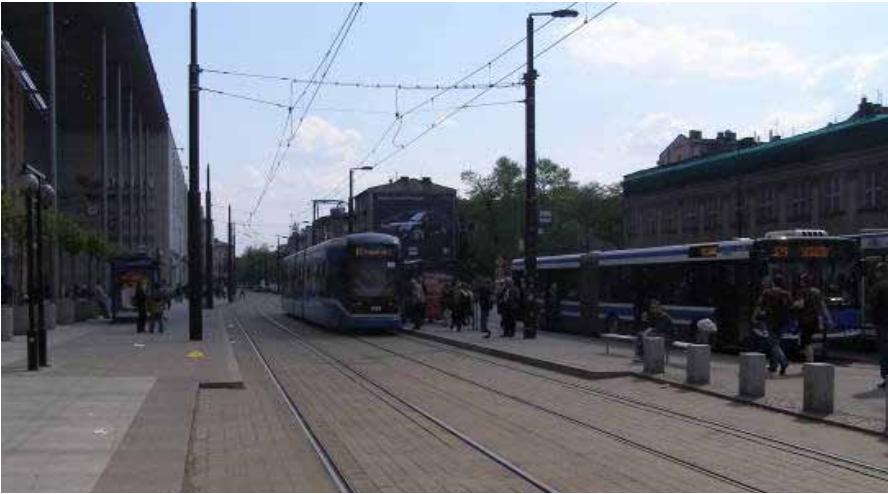
Rys. 5. Nowe torowisko tramwajowe w pobliżu kampusu PK przy ul. Warszawskiej
