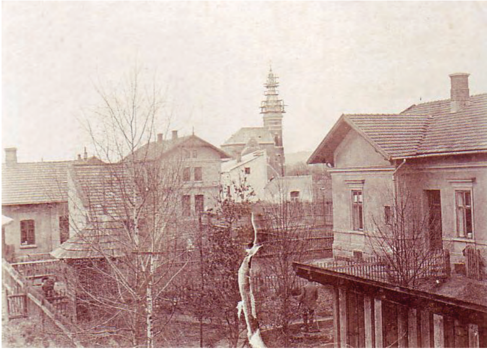
Fot. 2. Widok spomiędzy domów Kolonii Robotniczej na kaplicę pw. św. Elżbiety – w budowie (rok 1898)
