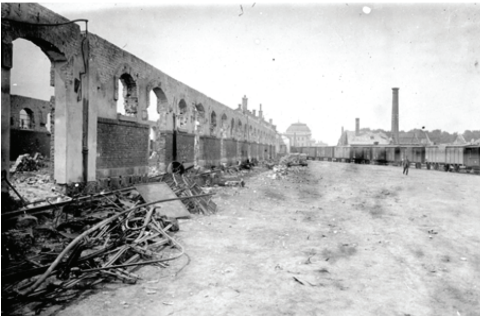
Fot. 5. Ruiny fabryki cykorii w sąsiedztwie tarnowskiej stacji kolejowej
