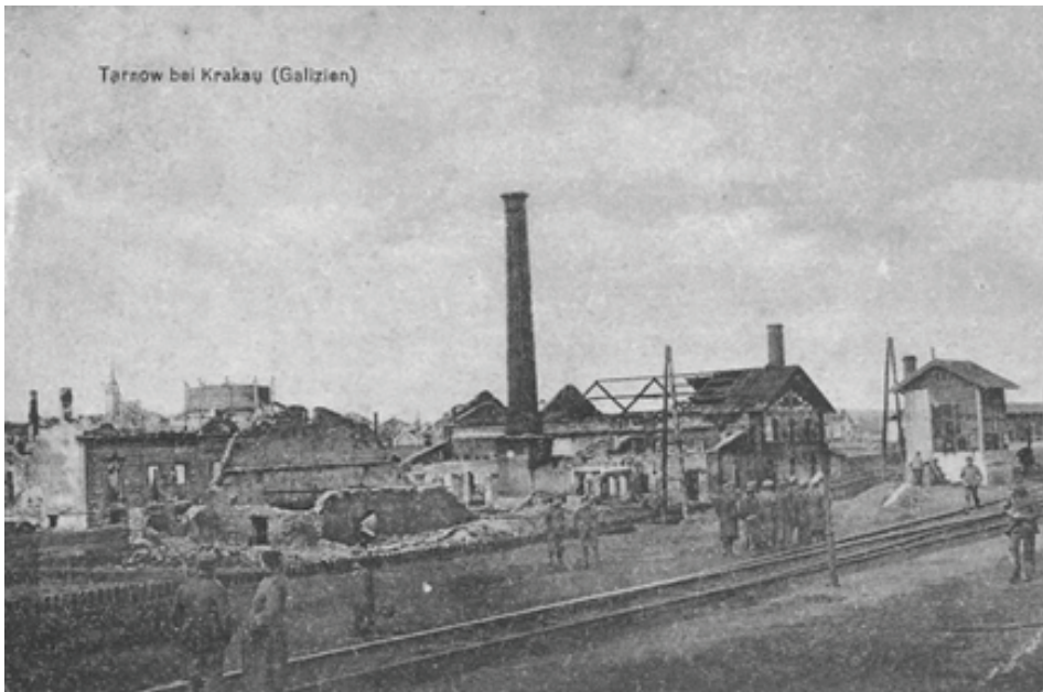
Fot. 4. Ruiny fabryki cykorii w sąsiedztwie tarnowskiej stacji kolejowej. Po prawej stronie widoczna budka nastawni kolejowej.
