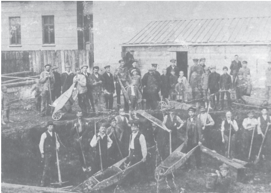
Fot. 4. Kolejarze podczas wybierania ziemi pod fundamenty Domu Robotniczego (rok 1901)
