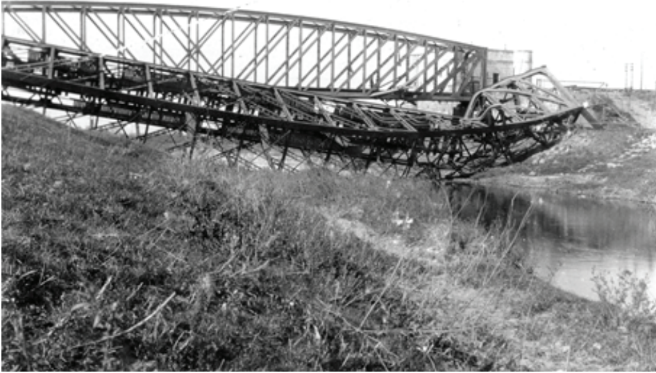
Fot. 2. Zniszczony most na rzece Białej. W tle budynek jednej ze strażnic.
