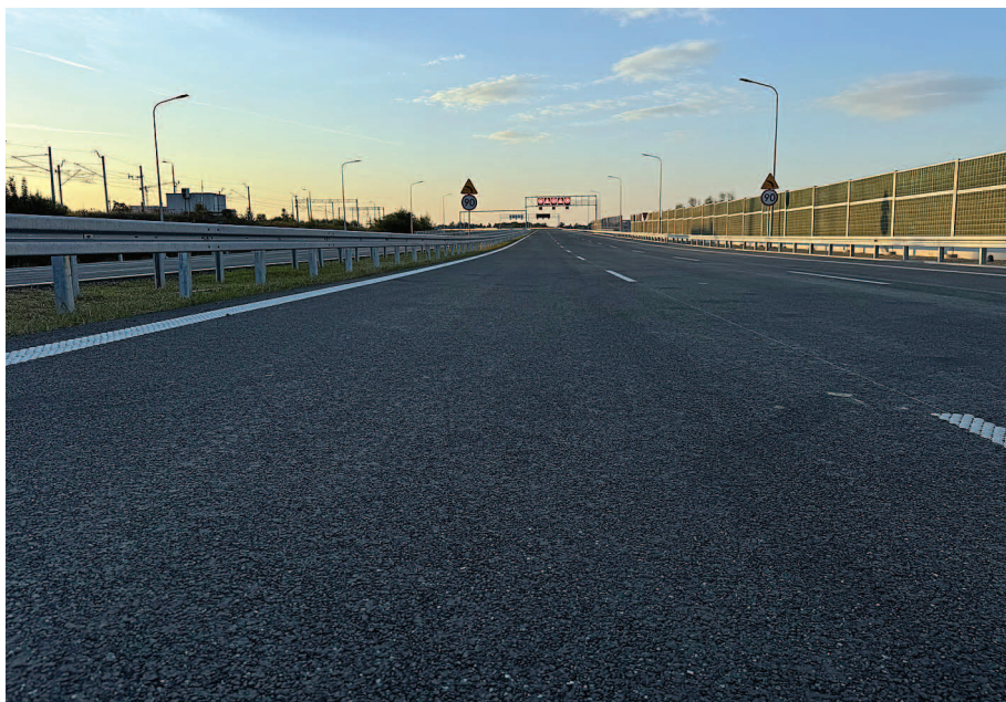
Fragment drogi ekspresowej S52
