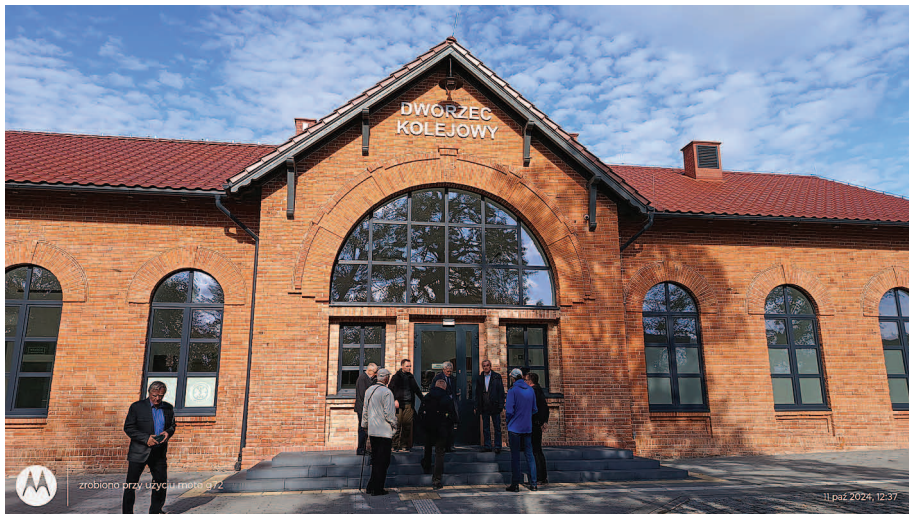
Zwiedzanie odrestaurowanego budynku zabytkowego dworca kolejowego Zduniska Wola
